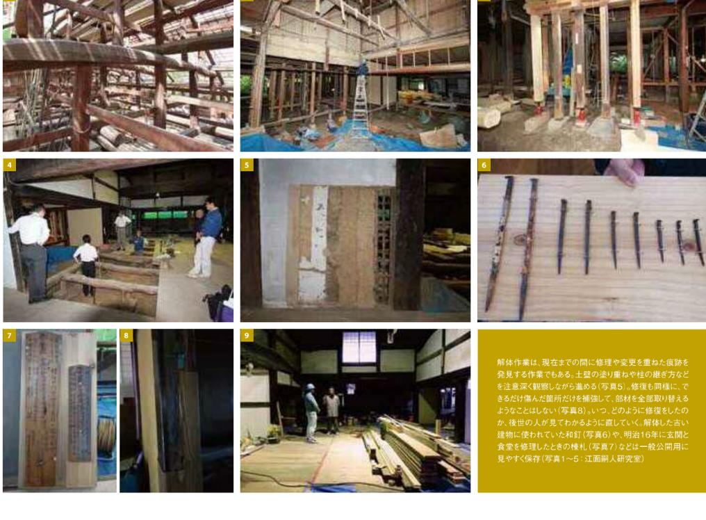
解体作業は、現在までの間に修理や変更を重ねた痕跡を発見する作業でもある。土壁の塗り重ねや柱の継ぎ方などを注意深く観察しながら進める（写真5）。修復も同様に、できるだけ傷んだ箇所だけを補強して、部材を全部取り替えるようなことはしない（写真8）。いつ、どのようにつくられたのか、後世の人が見てわかるように直していく。解体した古い建物に使われていた和釘（写真6）や、明治16年に玄關と食堂を修理したときの棟札（写真7）などは一般公開用に見やすく保存（写真1～5：江面嗣人研究室）
